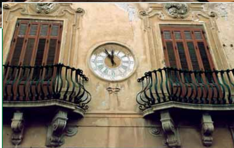
Дворец Ferro – Трарани – Италия Защита и отделка фасада с помощью: MAPE-ANTIQUE MC, MAPE-ANTIQUE RINZAFFO, SILEXCOLOR PRIMER, SILEXCOLOR TONACHINO
