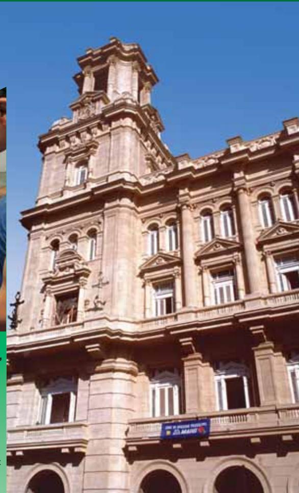
Asturiano Centre Building – Гавана – Куба Восстановление и защита фасада здания с использованием: MAPEGROUT THIXOTROPIC, MAPEFER, MAPE-ANTIQUE FC, MAPE-ANTIQUE MC, MAPE-ANTIQUE LC, SILEXCOLOR PAINT
